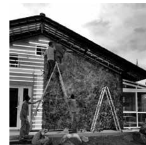
Instalação das placas Corstone
